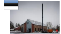
Kotelna na biomasu, Kohila Estonsko
