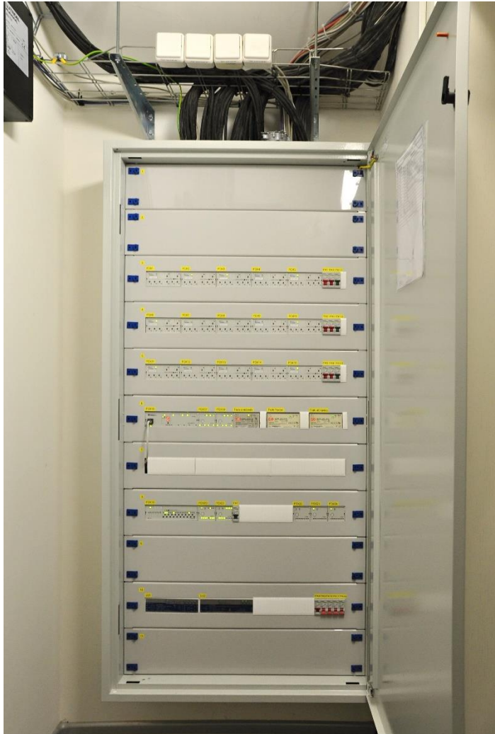
Zakrytovaný rozvaděč v RD
